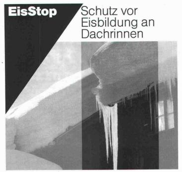
Schnee auf dem Dach wird zum Problem, wenn er durch Sonneneinstrahlung und Gebäudewärme zu schmelzen beginnt und dann wieder gefriert. Eis baut sich auf, Fallrohre platzen, Dachrinnen verbiegen sich, Wasser staut sich zurück, bis ins Haus. Umfangreiche Reparaturen, Ärger und hoher Schadenersatz sind die Folgen.
