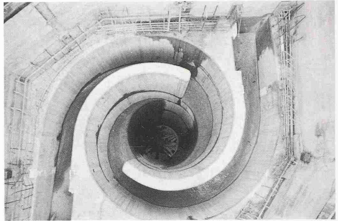
Bild 6. Wirbelfallschacht Höngg im Bau
