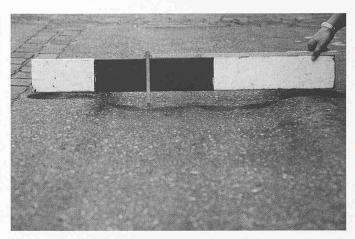
Bild 3. Stark verformter Belag unter Busverkehr
