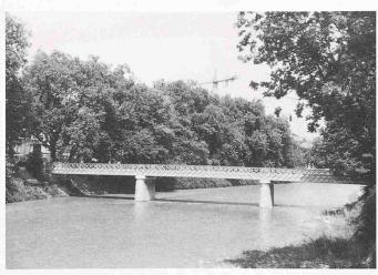
Bild 9. Militärbrücke, ehemalige schweisseiserne Hauptträger als Geländer verwendet, Spannbetonplatte als neue Tragkonstruktion
