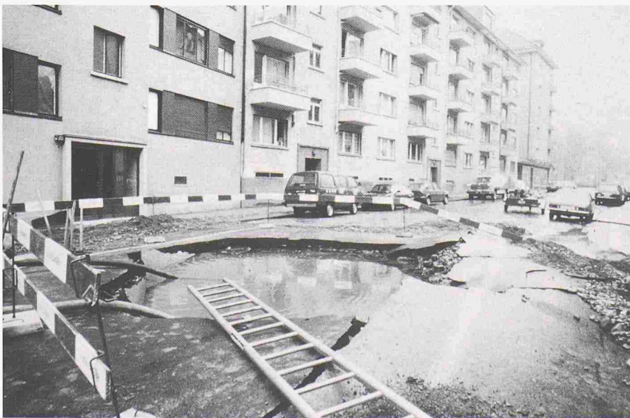
Bild 4. Strassenschäden infolge eines Wasserleitungsbruchs
