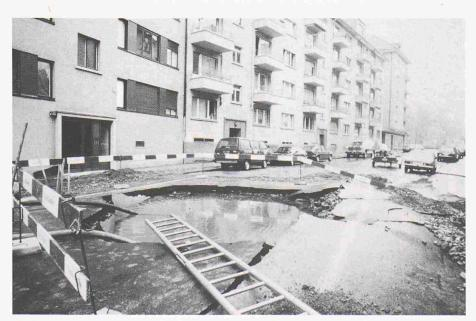
Bild 4. Strassenschäden infolge eines Wasserleitungsbruchs
