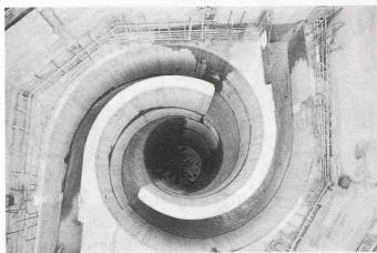
Bild 6. Wirbelfallschacht Höngg im Bau
