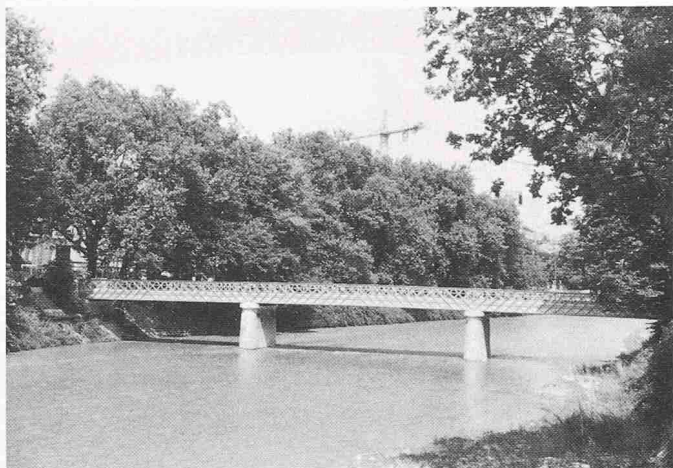
Bild 9. Militärbrücke, ehemalige schweisseyserne Hauptträger als Geländer verwendet, Spannbetonplatte als neue Tragkonstruktion
