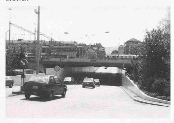
Bild 11. Unterführung Langstrasse, ehemalige Stahlbogenbrücke ersetzt durch eine Rahmenkonstruktion
