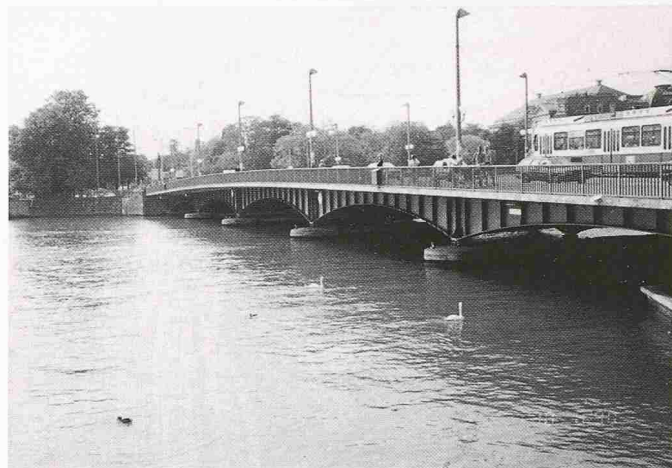
Bild 10. Quaibrücke, erbaut 1884, erneuert 1984
