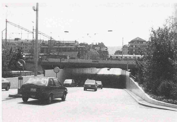
Bild 9. Militärbrücke, ehemalige schweisseyserne Hauptträger als Geländer verwendet, Spannbetonplatte als neue Tragkonstruktion
