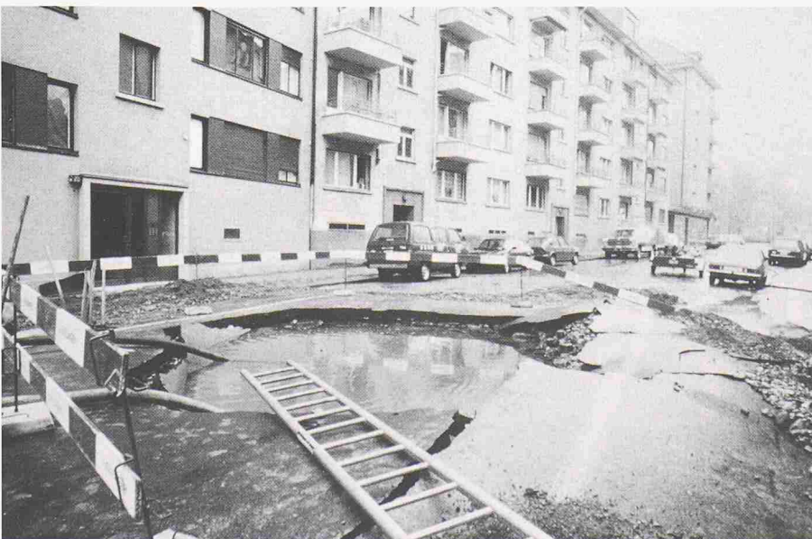
Bild 4. Strassenschäden infolge eines Wasserleitungsbruchs
