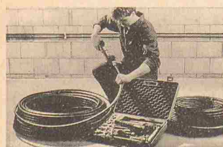
Bequemes Verarbeiten des Mepla-Versorgungsrohres auf der Baustelle
