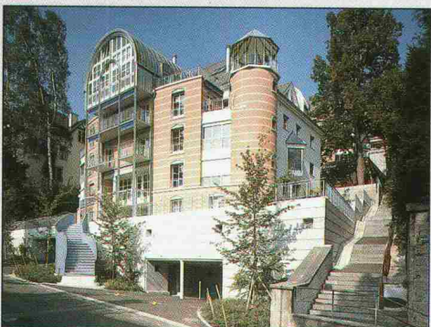
Mehrfamilienwohnbaus, St. Gallen Planung: Müller + Bamert, dipl. Arch. SIA/ETH, 9000 St. Gallen Ausführung der Spenglerarbeiten: Domeisen AG, 9016 St. Gallen
