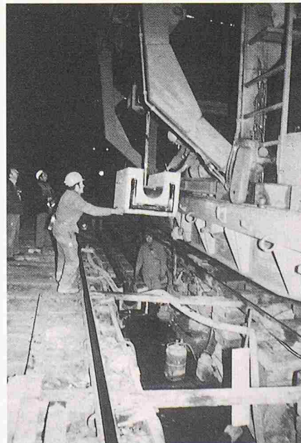
Bild 2. Die Sanierungsarbeiten im Hauenstein-Basistunnel wurden unter vollem Zugsbetrieb durchgeführt: hier das Versetzen der vorfabrizierten Elemente der Haupttrigolen (Bild: ETH)
