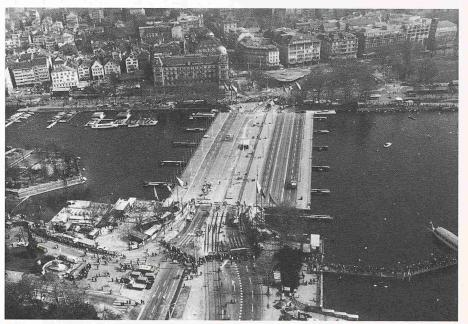
Bild 5. Spektakuläre Aktion im März 1984: Die alte Quaibrücke in Zürich wird seitlich verschoben und macht der neuen Brücke Platz (Bild: Comet)
