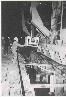
Bild 2. Die Sanierungsarbeiten im Hauenstein-Basistunnel wurden unter vollem Zugsbetrieb durchgeführt: hier das Versetzen der vorfabrizierten Elemente der Hauptrigolen (Bild: ETH)
