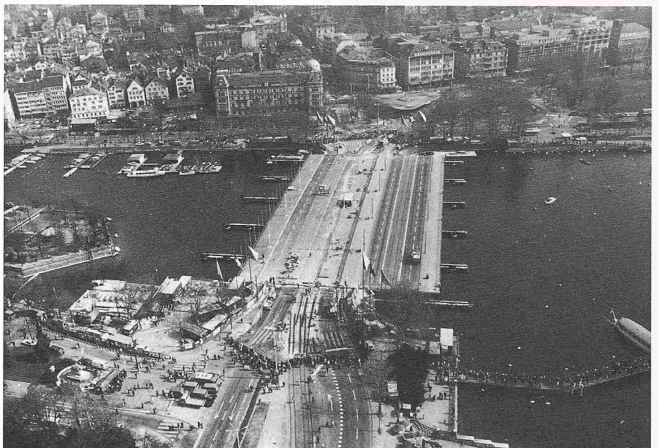
Bild 5. Spektakuläre Aktion im März 1984: Die alte Quaibrücke in Zürich wird seitlich verschoben und macht der neuen Brücke Platz (Bild: Comet)
