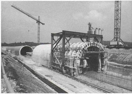
Bild 1. Viele Verkehrswege müssen für heutige Verhältnisse ausgebaut werden, wie etwa das Streckennetz für die Bahn 2000. Im Bild die Grossbaustelle des Grauholztunnels, der teilweise im Tagbau erstellt wird (Bild: Comet)
