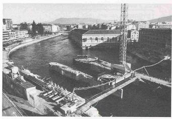
Bild 4. Die Energieversorgung kann durch Aus- oder Neubau veralteter Anlagen verbessert werden: In Genf wird eine neue Kraftwerkanlage und Stauhaltung die alte Seujet-Anlage ersetzen (Bild: Comet)
