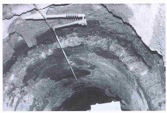
Bild 5. Neue Fahrleitung in einem ausgebrochenen Ring
