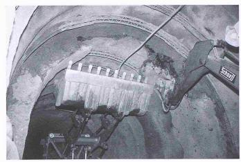
Bild 6. Hydraulischer Abbauhammer auf Bagger (Vordergrund)
