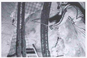
Bild 7. Neu entwickelter Gitterträger (der Profilform anpassbar)
