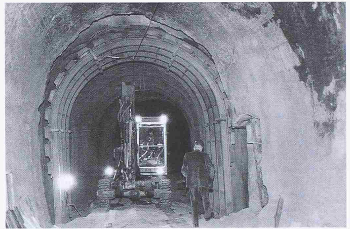
Bild 9. Stahlschutzschild im Bereich eines frisch ausgeweiteten Abschnitts
