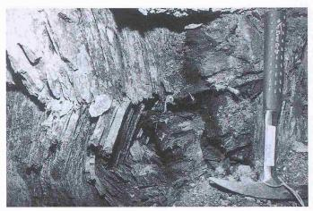
Bild 3. Lokale Knickzone hinter der alten Betonverkleidung
