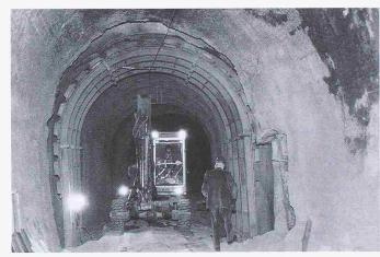
Bild 9. Stahlschutzschild im Bereich eines frisch ausgeweiteten Abschnitts
