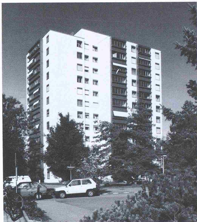
Bild 1b. Zustand nach der Fassadensanierung. Massgebend für die Auszeichnung war neben der Sanierung der Haustechnik die gute konstruktive Lösung der hinterlüfteten Fassade mit Keramikplattenverkleidung sowie die Integration der Balkone mit Faltfenstern
