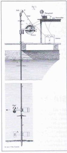
Bild 2. «Elektrischer Integrator» von Harlacher. Von einem Floss aus wird eine Stange in den Fluss gestellt, längs welcher der Messflügel gleichmässig auf und ab bewegt wird. Seine elektrisch übermittelte Drehzahl gibt die durchschnittliche Fliessgeschwindigkeit des Flusses am Ort der Stange an. Zeichnung von 1881
