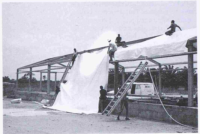
Bild 4. Montage der PVC-Sarnafil-Membrane
