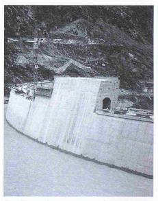
Die Bogenstaumauer von Mauvoisin im Wallis wird zurzeit um 13,5 m erhöht (Bild: Elektrowatt)
