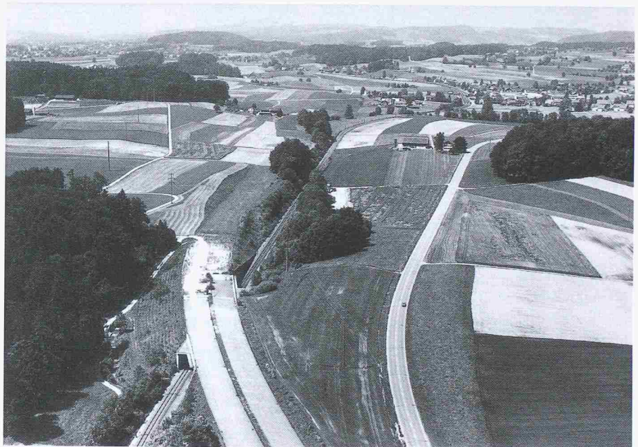
Im Knonaueramt wird die Inbetriebnahme des bereits erstellten N4-Teilstücks zwischen der Zuger Kantonsgrenze und Knonau vorbereitet. Flankierende Massnahmen gegen noch mehr Immissionen in den umliegenden Dörfern sind vorgesehen (Bild: Comet)
