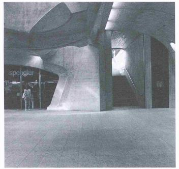
Bild 5. Untergeschoss: Stützen des Gleistroges, Durchlass des Tageslichtes
