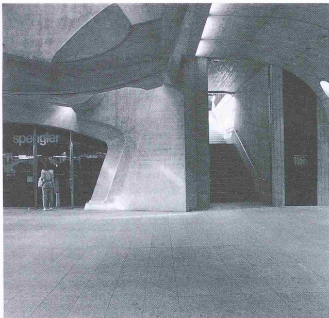
Bild 5. Untergeschoss: Stützen des Gleistrogges, Durchlass des Tageslichtes
