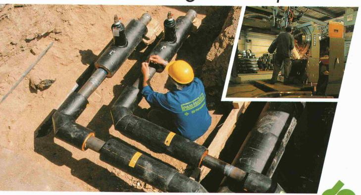
Bei Fernwärme-Systemen ist Sicherheit alleroberstes Gebot. Selbstverständlich sind die Rohre wichtig – entscheidend für die Sicherheit sind aber die Formteile. Hier geht's um die Wurst.
