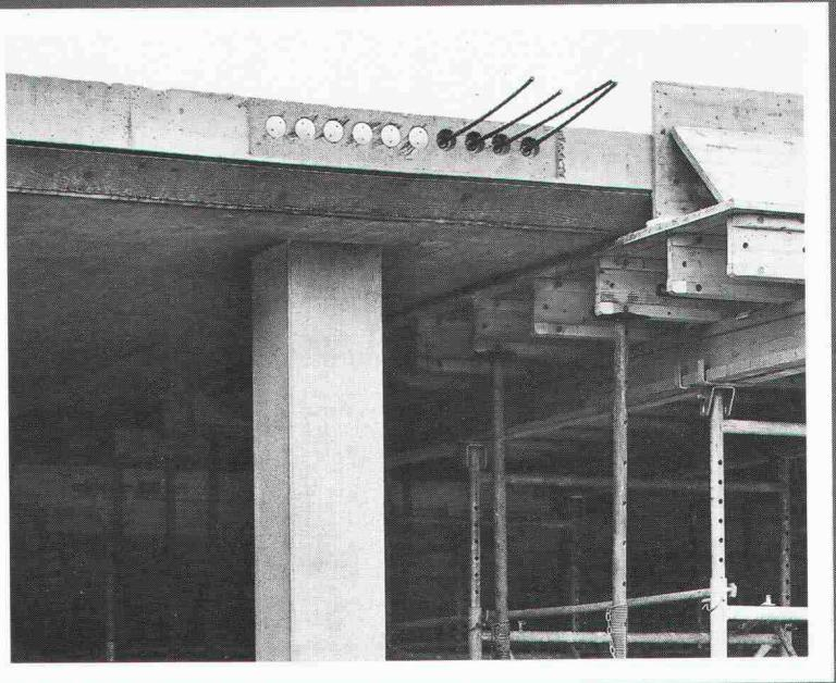
**Decken mit Stahlt<sup>on</sup> Stützstreifen-Vorspannung** erfüllen alle diese Bedingungen mit Leichtigkeit. Vorfabrizierte Stützen aus hochfestem Beton können extrem schlank ausgebildet werden. Querschnitt, Oberfläche und Anschlussdetails richten sich nach Ihren Wünschen und Anforderungen.
