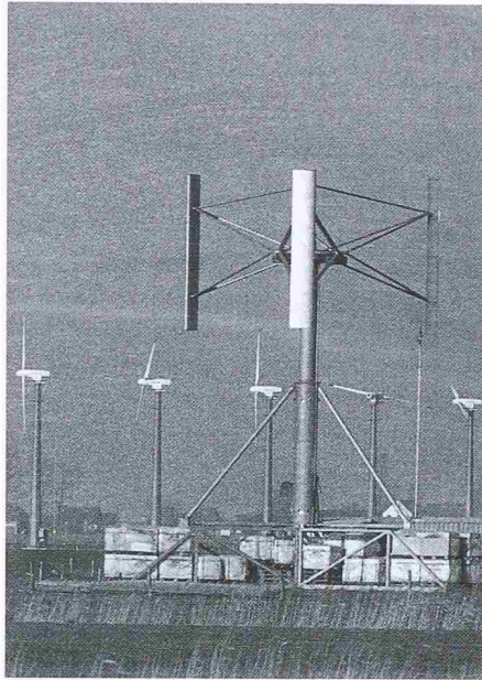
Neuartiges Windrad mit H-Rotor auf vertikaler Drehachse (Bild: Keystone)
