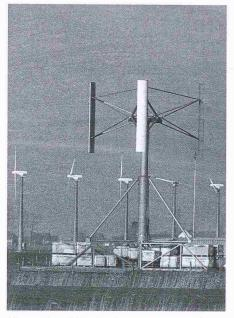
Neuartiges Windrad mit H-Rotor auf vertikaler Drehachse (Bild: Keystone)
