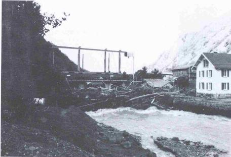
Bild 4. Diese spektakuläre Verklausung ereignete sich am Wehr der Fassung in Mörel des SBB – Kraftwerkes Massaboden. Durch den anschliessenden Rückstau des Rotten wurde die direkt oberhalb des Wehres liegende Zentrale der Rhonewerke überflutet und beschädigt. (Foto Rhonewerke AG, Ernen)
