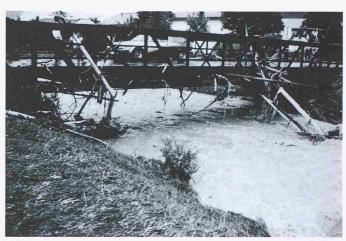
Bild 9. Brücke über die Alp nach dem Hochwasser 1984. Eine bergseitige Verschalung hätte hier das Hängenbleiben von Holz verhindert (Foto Baudepartement des Kt. Schwyz, Abt. Wasserbau)
