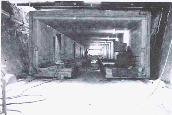
Bild 5. Vorschub des Tunnelkastens
