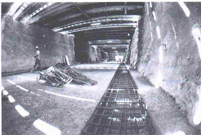
Bild 3. Vernagelte Steilwand und Hilfsbrücken
