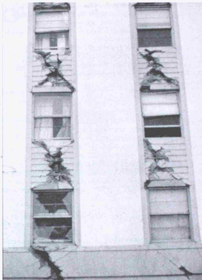
Bild 4. Schäden am Mt. McKinley-Gebäude nach dem Erdbeben von Anchorage, 1964, Alaska
