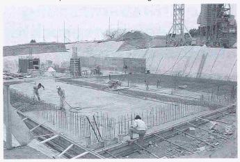
richtung und der zulässigen mittleren Bodenpressung. Die erforderliche Dikke ergab sich aufgrund eines ausreichenden Durchstanzwiderstandes. Der Biegewiderstand in Querrichtung wird ausschliesslich mit schlaffer Bewehrung gewährleistet, während in Längsrichtung hauptsächlich die Vorspannkabel und eine Minimalbewehrung dazu beitragen.
