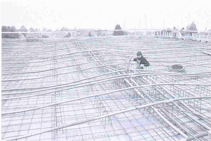
Bild 3. Vorspannbewehrung der Decken
