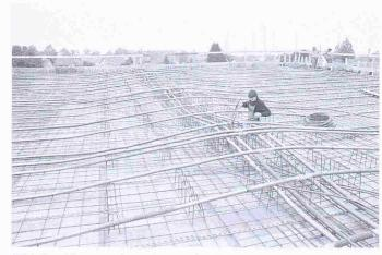
Bild 3. Vorspannbewehrung der Decken
