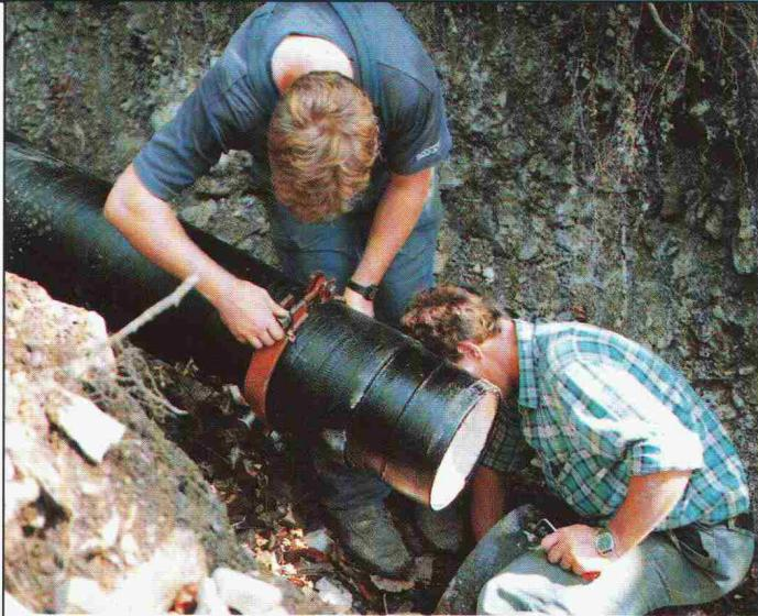
**P**roblemlose Rohrmontage auch in schwierigem Gelände: Während der Meister das Rohr-Spitzenende sorgfältig säubert, montiert der Geselle bereits die Schelle für das Verlegegerät. Deutlich erkennt man am Spitzende den FZM-Panzer, die bereits werkseitig aufgebrachte Schweißraupe für die Schubsicherung TIS-K sowie die ZM-Innenbeschichtung.
