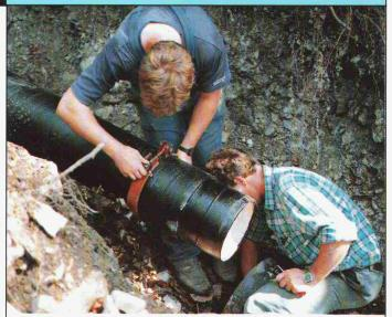
roblemlose Rohrmontage auch in schwierigem Gelände: Während der Meister das Rohr-Spitzende sorgfältig säubert, montiert der Geselle bereits die Schelle für das Verlegegerät. Deutlich erkennt man am Spitzende den FZM-Panzer, die bereits werkseitig aufgebrachte Schweissraupe für die Schubsicherung TIS-K sowie die ZM-Innenbeschichtung.
