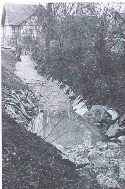
Bild 2. Blockrampe Mederbach Martha- len mit Fischgumpen, kurz nach der Fertigstellung Dezember 1984, Blick bachabwärts
