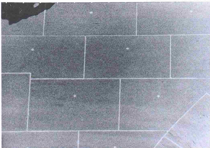
Bilder 8, 9. Während die «bis auf den gesunden Grund» zurückgearbeitete Fassade mit neuen Fugen starr und neubauartig-maschinell wirkt, bleiben an der lediglich gereinigten, nach Notwendigkeit ausgefugten Partie die Bearbeitungs- und Altersspuren lesbar
