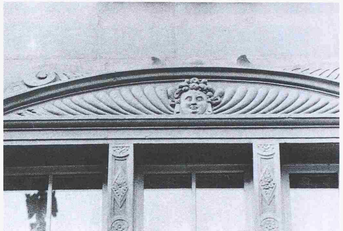
Bild 11. Bildhauerarbeit aus dem 16. Jahrhundert nach zurückhaltender Aufmörtelung
