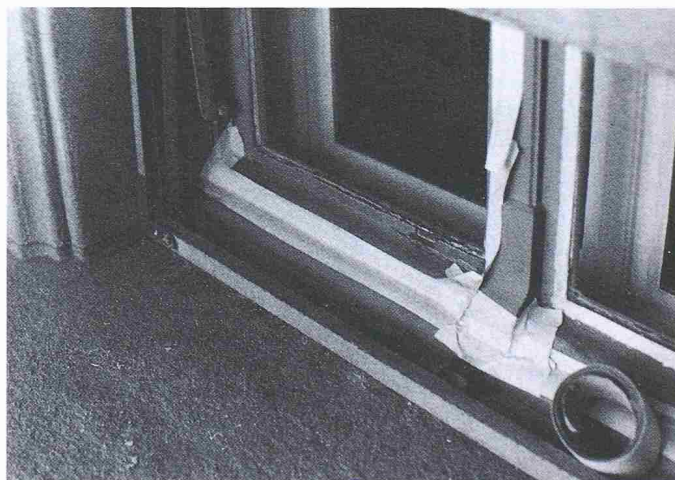
Bild 1. Jede Nassreinigung an einem Gebäude erfordert eine sorgfältige Abdichtung allfällig offener Fugen
