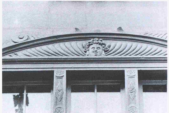
Bild 11. Bildhauerarbeit aus dem 16. Jahrhundert nach zurückhaltender Aufmörtelung
