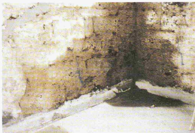
Bild 2. Mauerwerkschaden durch aufsteigende und hygroscopische Feuchtigkeit
