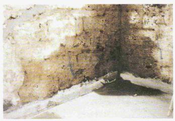
Bild 2. Mauerwerkschaden durch aufsteigende und hygroskopische Feuchtigkeit
