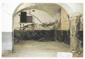
Bild 7. Mauerwerkschäden im Gewölberaum
