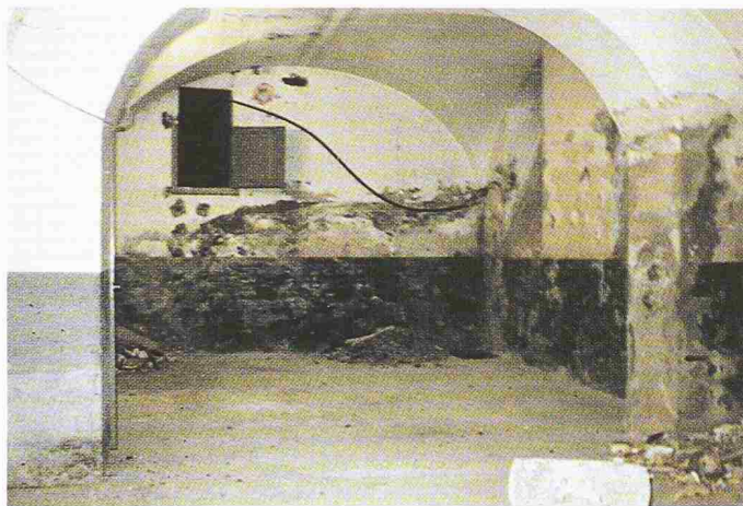
Bild 7. Mauerwerkschäden im Gewölberaum
