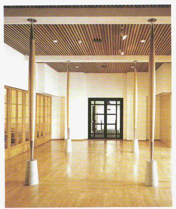
Damit die beiden gegenüberliegenden Mehrzweckräume zusammengelegt werden können, sind die Tragmauern des Korridors durch gedrechselte Eichenstützen ersetzt worden. Die Kräfte des quer eingespannten Dachstuhls werden durch diese vier Nadelstützen auf die unteren längsliegenden Tragmauern übertragen
