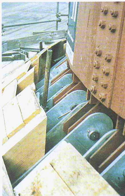
Bild 40. Der obere Anschluss nach der Montage. Die Gelenkbolzen sind mit Splinten gesichert
