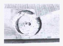
Bild 9. Nachgebohrte Ringdübelverbindung. Unsachgemäss ausgeführte Verbindungen sind oft Ursache für Schadenfälle
