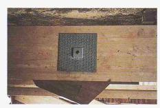
Bild 11. Durch die Konzentration der Nägel um das Bolzenloch und Ausnützung der Stabbreite kann eine Abminderung der zulässigen Nagelbeanspruchung umgangen werden
