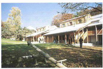
Ansicht des fertigen Gebäudes. Sowohl Konstruktion als auch alle Verkleidungen sind in Lärche ausgeführt
