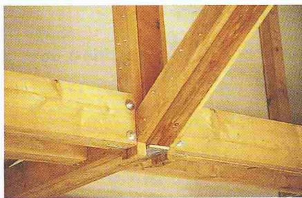
Bild 31. Ansicht des fertig montierten Knotens. Die Verbindung der zusammengesetzten Querschnitte erfolgte mit Schraubnägeln
