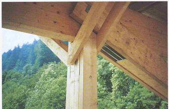
Bild 35. Die Verbindungen zur Aufnahme der grossen Stabkräfte (bei diesem Obergurt-Knoten 700 kN Druck in der Diagonalen und 350 kN Zug im Pfosten) sollten möglichst diskret wir-
