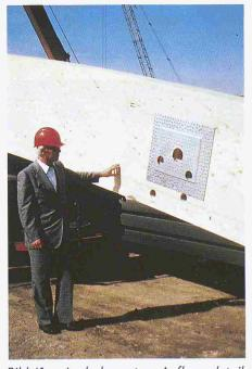
Bild 41. Auch das untere Auflagerdetail ist mit einer Gelenkbolzen-Verbindung konstruiert. Die zusätzlichen Bohrlöcher dienen der Kraftübertragung des Aussteifungssystems und sind ohne Einfluss auf die Abtragung der vertikalen Lasten
