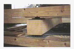
Bild 10. Die Ausführungsqualität von Gelenkbolzen-Verbindungen kann auch nach dem Zusammenbau gut kontrolliert werden. Untergurtanschluss eines Fachwerkes mit Posten aus Holz und Diagonalen aus Stahl
