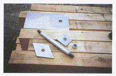
Bild 8. Einzelteile der Gelenkbolzen-Verbindung: Nagelblech mit Lochverstärkung, Bolzen und Unterlagsscheibe
