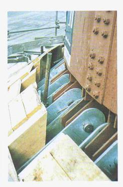
Bild 40. Der obere Anschluss nach der Montage. Die Gelenkbolzen sind mit Splinten gesichert
