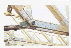
Bild 12. Langes Nagelblech infolge geringer Stabbreite. Die Nagelbelastung muss abgemindert werden. Durch die aussenliegenden Nagelbleche erhält der Gelenkbolzen eine zusätzliche Biegebeanspruchung
