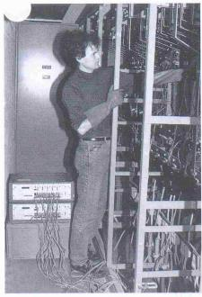
Bild 1. Installation des Messsystems in der Elektrohauptverteilung
