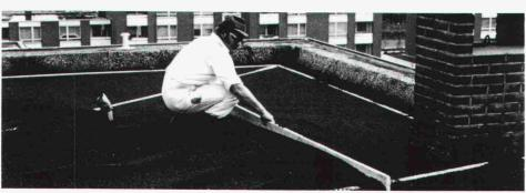
Das Material wird nach dem Anmischen mit Perlmix im gewünschten Gefälle über vorher ausgerichtete Lehren abgezogen. Nach dem Verdichten kann Thermoperl begangen werden.
