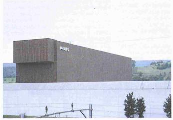
Bild 6. Referenzaufnahme Metallfassade des Philips-Lagerhauses; ausgeführt in Silikonpolyesterlack; Baujahr 1973
