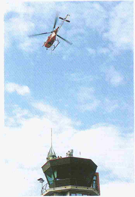
Bild 8. Blitzschutzprüfung des neuen Kontrollturms des Flughafens Lugano-Agno anhand einer hochfrequenten Stromeinspeisung
