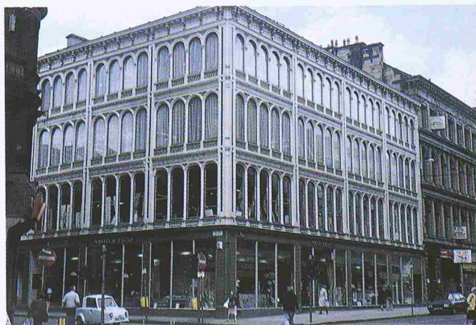
Gardner's Warehouse, Gusseisen und Glas in Vorfabrikation, John Baird 1856
