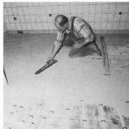
00.00 Der SME-H-Estrich wird aufgetragen,
