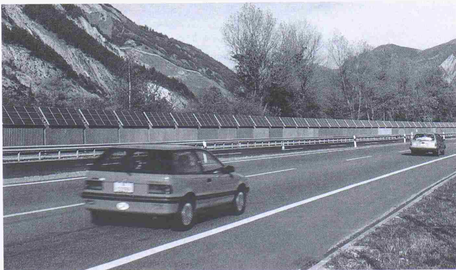
Die Photovoltaik-Anlage (100 kW) entlang der Autobahn N13 bei Chur
