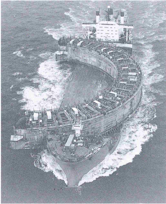
Bild 2. Einschwimmen eines der beiden Teile der Spannbeton-Schutzwand für die Ekofisk-Ölspeicherinsel in der Nordsee (hbw) – Betonpreis [20]
