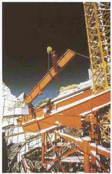
Bild 2. Auch unter schwierigsten Witterungsbedingungen lassen sich Verbundbauten sicher und schnell erstellen, wie dieses Bild von der Montage des «Top of Europe» in 3500 m Höhe auf dem Jungfraujoch beweist.
