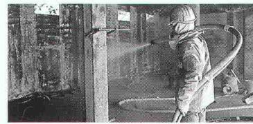
Zur Reprofilierung und strukturellen Verstärkung des Bauwerkes wird bei Renesco auch das Spritzbeton- und Spritzmörtel-Verfahren eingesetzt.
