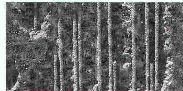
Dem Schaden auf den Grund gehen heißt meistens: korrodierte Eisen freilegen.
