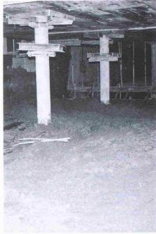
Bild 10. Aushub bei der Deckelbauweise
