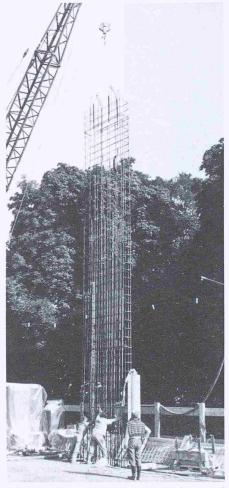
Bild 3. Armierungskorb für Schlitzwand
