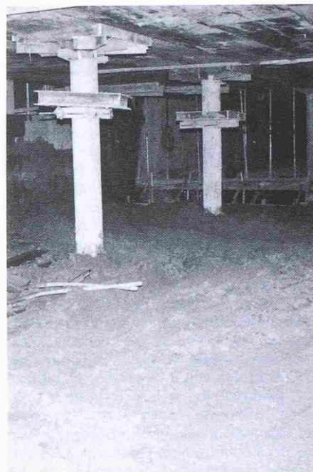
Bild 10. Aushub bei der Deckelbauweise
