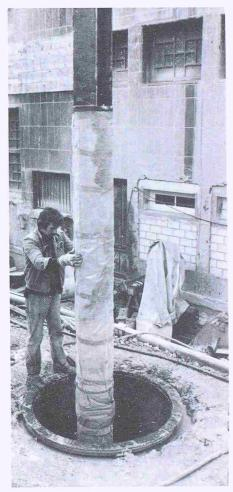
Bild 4. Stütze beim Versetzen
