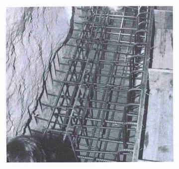
Bild 7. Anschluss Bodenplatte – Schlitzwand
