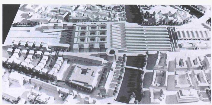
Modellaufnahme des Projektes entsprechend den Empfehlungen des Beirates, 1990. Rechts im Bild ist der bestehende Hauptbahnhof zu sehen und daran anschliessend die bestehenden Perrons, angrenzend an die Sihl die Bahnhofhalle Südwest mit dem anschliessenden Dienstleistungszentrum. Zwischen Sihlpost und Bahnhofhalle Südwest befindet sich das Hotel. Entlang dem Gleisfeld ordnen sich die Wohnbauten an, welche auch den Schul- und Gewerbeteil umfassen. Bild: Monika Bischof
