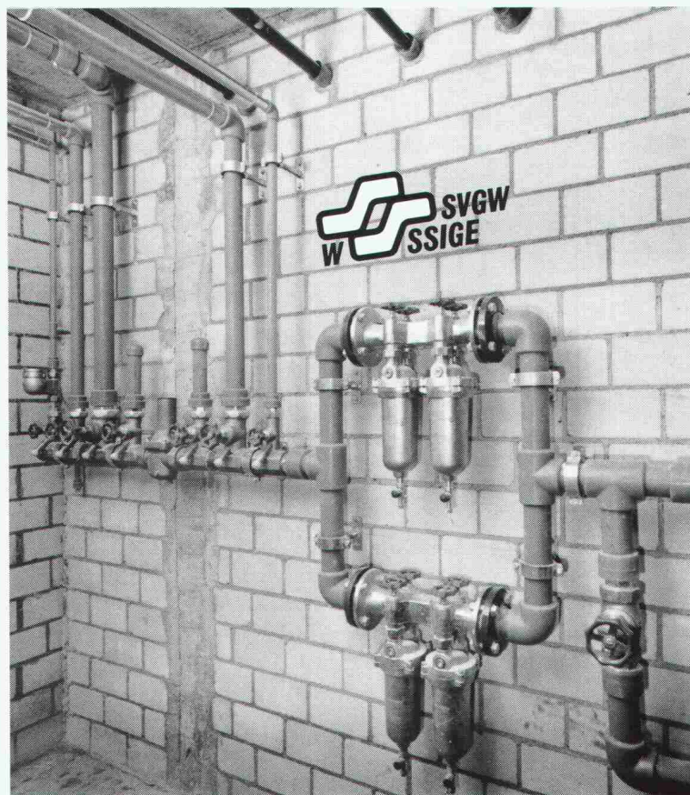
Verteilerbatterie in der Mövenpick-Raststätte «Heidiland» bei Sargans
