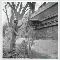
Die aufliegende Betonkonstruktion muss abgebrochen werden. Um das als Auflage dienende, unter Heimat- und Naturschutz stehende Sandsteinmauerwerk nicht zu beschädigen, wird mit einer Diamantkreissäge horizontal ein Trennschnitt erstellt. ... bohren
