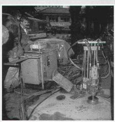
Der Abbruch von Betonteilen mit extrem grossen Ausmassen wird aus wirtschaftlichen Gründen durch Perforationsbohrungen oder mit hydraulischen Sprenggeräten ausgeführt.
