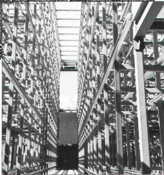
Stahlkonstruktion des Hochregallagers COOP Zürich LVZ
