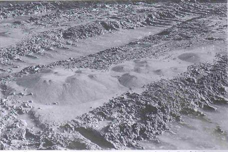
Foto: Vulkanartige Materialausschwemmungen unter Verlust der Tragfähigkeit einer Baugrubensohle infolge hydraulischem Grundbruch
