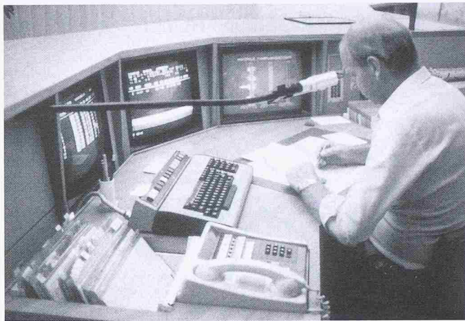
Bild 5. Das datengesteuerte Betriebsleitsystem erfasst jede Strassenbahn und jeden Bus auf 10 Meter genau. Der Computer vergleicht laufend den Ist- mit dem Soll-Standort und zeigt Abweichungen an, auf welche mit geeigneten Massnahmen – Einsatzfahrzeuge, Umleitungen usw. – reagiert werden kann
