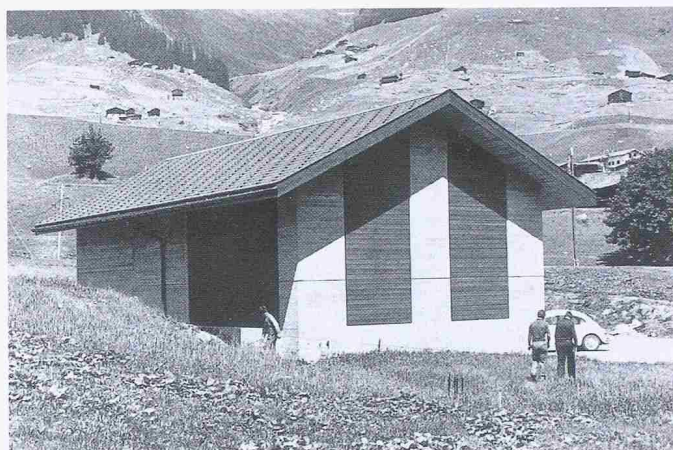
Bild 4. Eines der wenigen in den letzten 10 Jahren neuerstellten Kleinwasserkraftwerke: Zentrale Val Giuf bei Sedrun mit einer Ausbauleistung von 1,5 MW und einer Jahresproduktion von 6,2 GWh.
