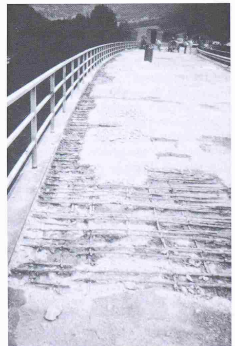
Bild 2. Verwitterungsschäden im Tiefbau
