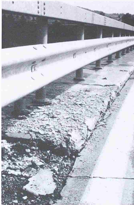
Bild 14. Zu dichter Schutzanstrich auf Betonkonsole. Kondensate darunter erhöhen Frostdruck, zusammen mit eingeschlossenen Chloriden sogar Frosttausalzbelastung. Der Beton wurde bei der Brücke dadurch überfordert
