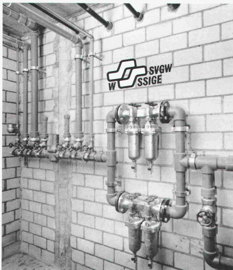
Verteilerbatterie in der Mövenpick-Raststätte «Heidiland» bei Sargans
