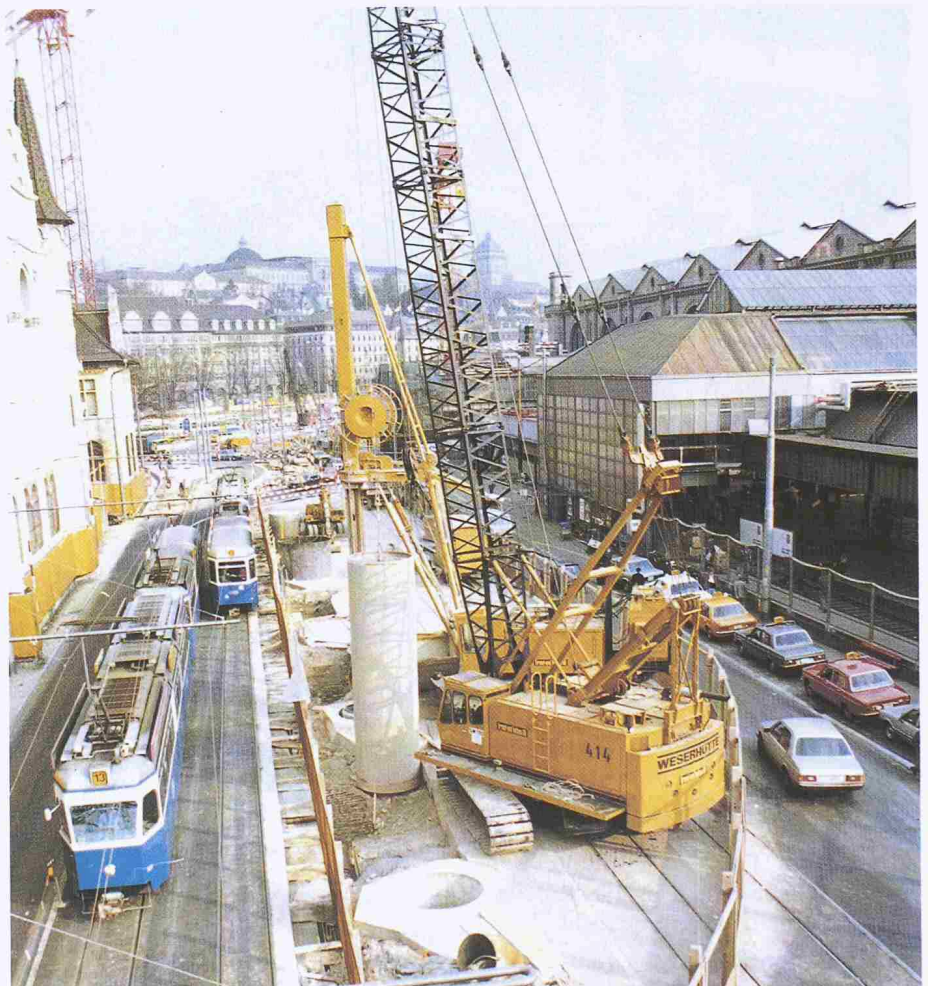
Bild 15. Bauarbeiten für die Pfahlfundationen in der Bauphase 2
