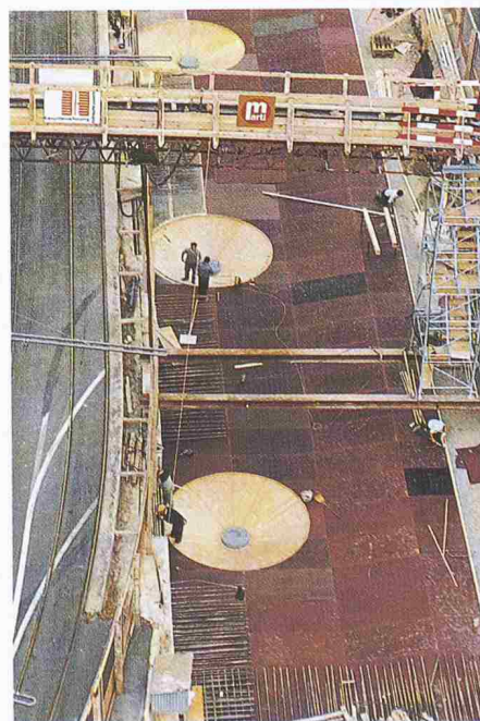
Bild 4. Decke über Fussgängergeschoss, Schalung
