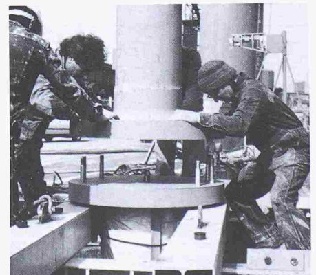
Bild 10. Verbinden der beiden Stützteile
