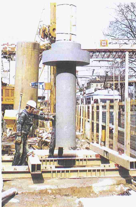
Bild 9. Versetzen der unteren Stütze
