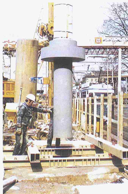
Bild 10. Verbinden der beiden Stützteile
