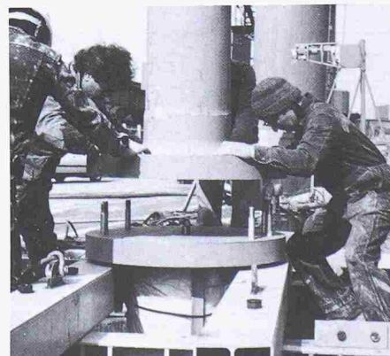
Bild 10. Verbinden der beiden Stützteile
