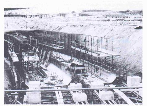
Ein in offener Bauweise gebauter Abschnitt des RTS-Zweiröhrentunnels. Im Hintergrund links das im Bau befindliche Abfertigungsgebäude des zukünftigen Londoner Flughafens Stansted
