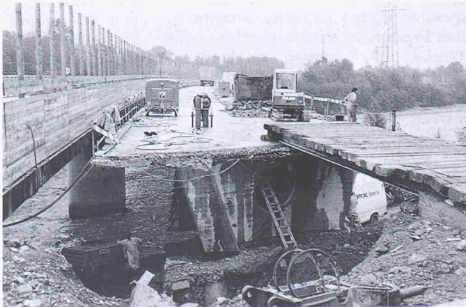
Bild 5. Autobahnbrücke Bad Ragaz wird momentan mit Microsilica-vergüteten Mörteln instandgestellt
