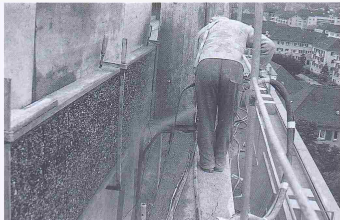
Bild 4. Applikation eines Besa-Spritzmörtels auf Microsilica-Basis (im Trockenspritzverfahren)
