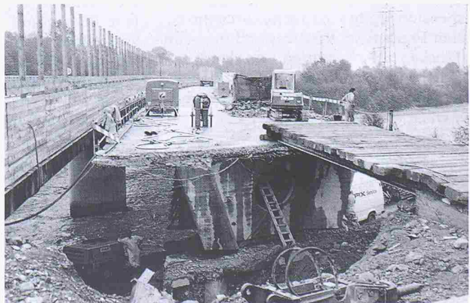
Bild 5. Autobahnbrücke Bad Ragaz wird momentan mit Microsilica-vergüteten Mörteln instandgestellt
