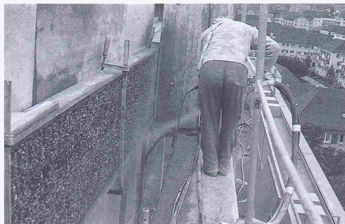
Bild 4. Applikation eines Besa-Spritzmörtels auf Microsilica-Basis (im Trockenspritzverfahren)
