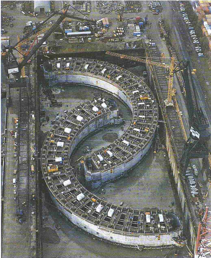
Bild 3. Herstellen einer Schutzwand für die Ekofisk-Plattform in zwei Teilen in Gleitschalung in einem Schiffsdock in Rotterdam aus Transportbeton mit Zusatz von Microsilica-Suspension (Spannbeton B 60) (de Jong)
