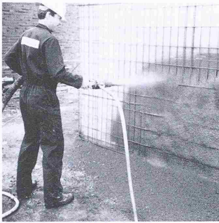
Bild 1. Durch den Zusatz von Microsilica wird die Auftragsdicke von Spritzbeton vergrößert und der Rückprall (5–10%) verringert (Herfurth)
