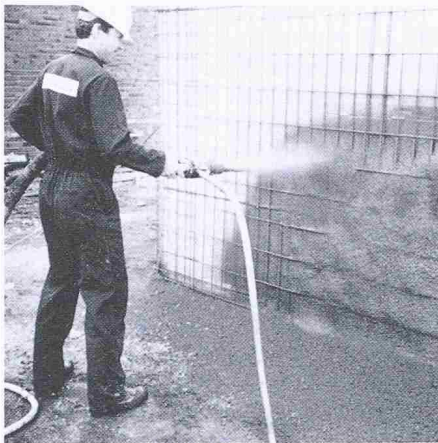
Bild 1. Durch den Zusatz von Microsilica wird die Auftragsdicke von Spritzbeton vergrössert und der Rückprall (5-10%) verringert (Herfurth)
