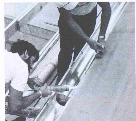
Durch Verschweissung oder Verklebung der Sarnatex-Unterdachbahn auf die Einlaufbleche werden die Traufanschlüsse rückstausicher ausgeführt
