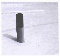
Sarnatex kann auch an Durchdringungen wie Dunstrohre wasserdicht angeschlossen werden
