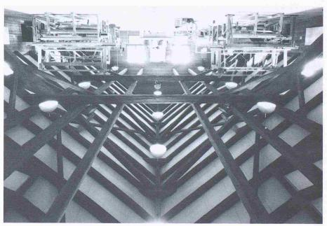
Der Architekt Werner Schmutz, Zofingen, hat das Bauernhaus mit Tenne zum Freizeitzentrum «Spittelhof» umgebaut. Das SarnaRoof-Unterdachsystem ist über der sichtbar bleibenden Tragkonstruktion aufgebaut, und es sorgt dafür, dass auch unter dem Dach, bei angenehmen raumklimatischen Bedingungen, einer sinnvollen Freizeitbeschäftigung nachgegangen werden kann
