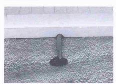
Gemäss Norm SIA 238 müssen Elektroleitungen raumseitig der Luftdichtigkeitsschicht angeordnet werden. Dieses Elektro-Lehrrohr ist über der Dampfsperre und Luftdichtigkeitsschicht verlegt und durchdringt diese. Die Dampfsperre muss an das durchdringende Elektro-Lehrrohr luftdicht angeschlossen werden
