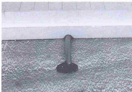
Gemäss Norm SIA 238 müssen Elektroleitungen raumseitig der Luftdichtigkeitsschicht angeordnet werden. Dieses Elektro-Lehrrohr ist über der Dampfsperre und Luftdichtigkeitsschicht verlegt und durchdringt diese. Die Dampfsperre muss an das durchdringende Elektro-Lehrrohr luftdicht angeschlossen werden
