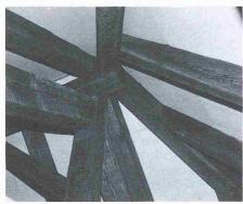
Bei einem solchen Dachstuhl ist es praktisch unmöglich, die erforderliche Luftdichtigkeit mit einer raumseitig der Tragkonstruktion liegenden Dampfbremse und Luftdichtigkeitsschicht zu gewährleisten
