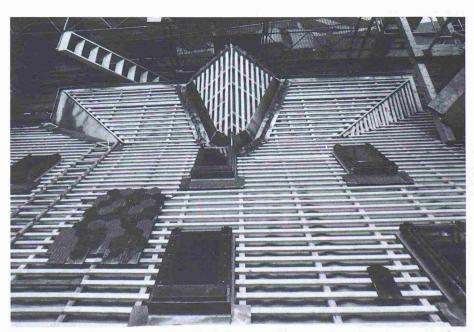
Das wasserdichte Sarnatex-Unterdach bietet auch unter alten Ziegeln dauerhaften Schutz vor infiltrierendem Wasser
