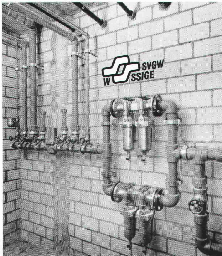
Verteilerbatterie in der Mövenpick-Raststätte «Heidiland» bei Sargans
