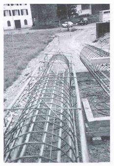
Bild 15. Der einbaufertige Armierungskorb
