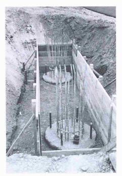
Bild 18. Die fertigen Spezialpfähle
