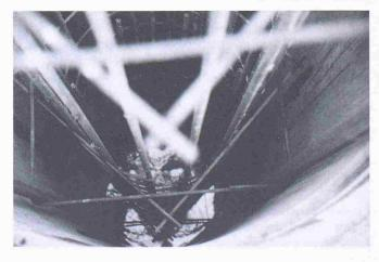
Bild 17. Die äusseren Bügel sind sehr eng in das Bohrrohr eingepasst.
