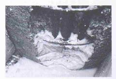
Bild 6. Detailaufnahme der Schadenstelle; ein Messrohr, zwei Stäbe der Biegebewehrung und die Spiralarmierung sind sichtbar
