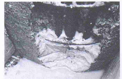
Bild 6. Detailaufnahme der Schadenstelle; ein Messrohr, zwei Stäbe der Biegebewehrung und die Spiralarmierung sind sichtbar
